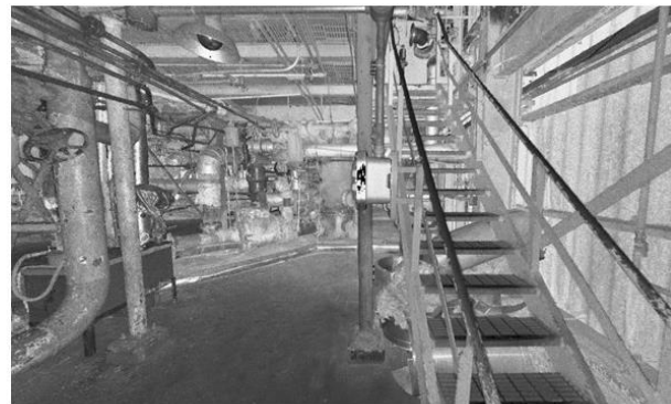
Imagen 06. Vista interna del ruteo de tuberías que va hacia el reactor y que sale del reactor. En la imagen de la derecha se puede apreciar una vista actual de la zona, y en la izquierda, el ruteo de la línea hacia el reactor y hacia el expansor. En esta vista se puede apreciar el sitio de la tubería donde se reubicará la válvula de control.
