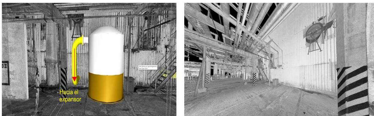
Imagen 08. Vista de la zona donde se planteó la ubicación Nro. 02 para el reactor y parte de la tubería que sale del reactor. La tubería mostrada es la que va hacia el expansor ubicado dentro de la planta de nítrico.
