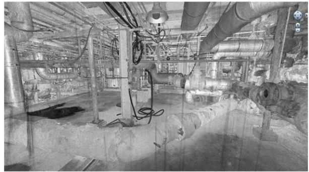
Imagen 12. Vista del ruteo de tuberías desde la zona donde se planteó la ubicación Nro. 02 para el reactor. La imagen de la derecha muestra el estado actual de la zona, y a la izquierda, el modelaje realizado del ruteo de las tuberías dentro de la planta. En esta vista se puede observar la ubicación de la válvula manual para dar facilidad operacional y de mantenimiento al reactor, y la reubicación de la válvula de control existente.
