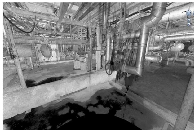
Imagen 11. Vista del ruteo de tuberías desde la zona donde se planteó la ubicación Nro. 02 para el reactor. La imagen de la derecha muestra el estado actual de la zona, y a la izquierda, el modelaje realizado del ruteo de las tuberías dentro de la planta.
